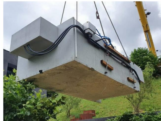
Pools mit Technik, alles vorgefertigt und montiert durch dade design / Pools – everything, including technique, prefabricated and assembled by dade design
